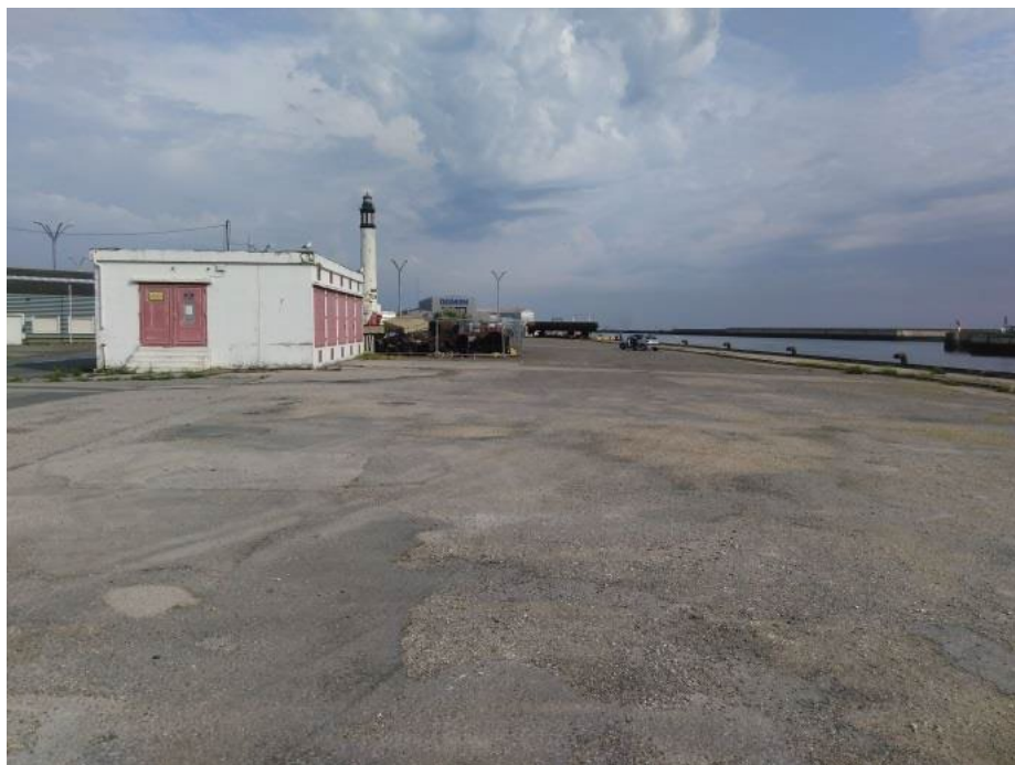
Vue générale de la zone d'implantation de la base de maintenance
