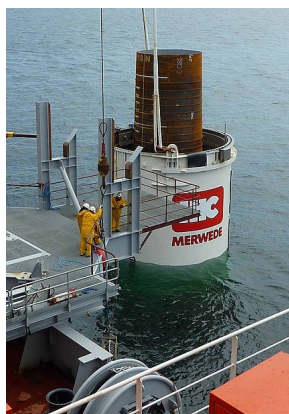
Détail de la solution de réduction "IHC-NMS" appliquée à l'atelier de battage (Source : Hemon et al., 2021).
