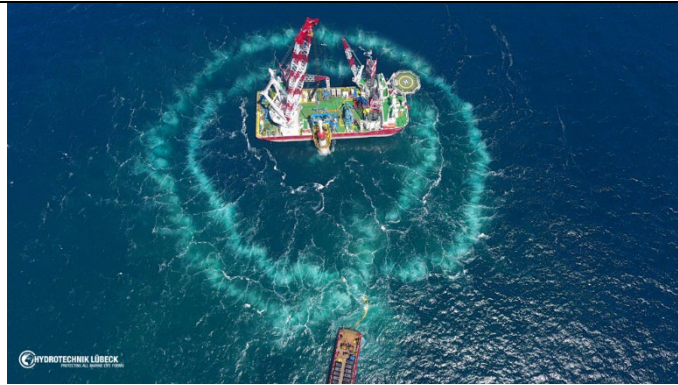
Exemple de double rideau de bulles (DBBC) (©Hydrotechnik Lübeck GmbH).
